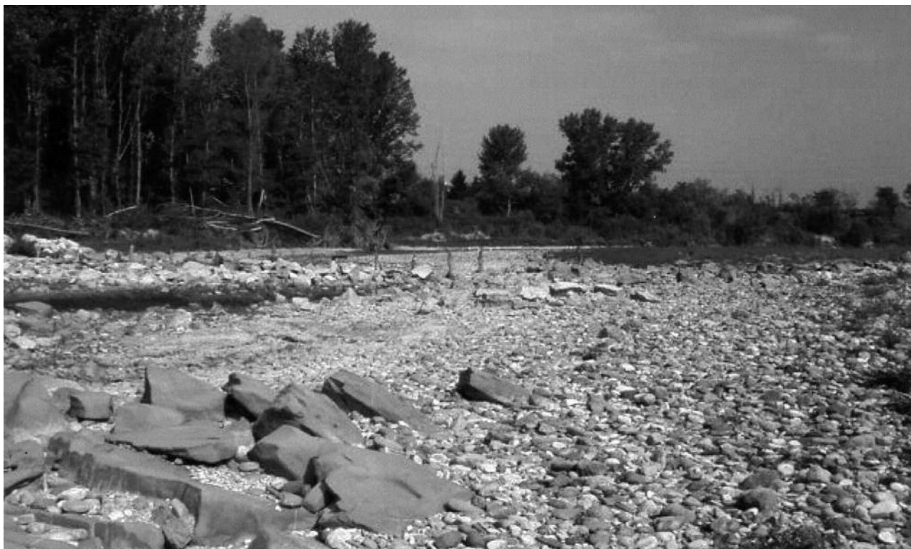
Il letto dell'Isonzo, attraversato dalle vestigia delle fondamenta del ponte; in alto un particolare.
