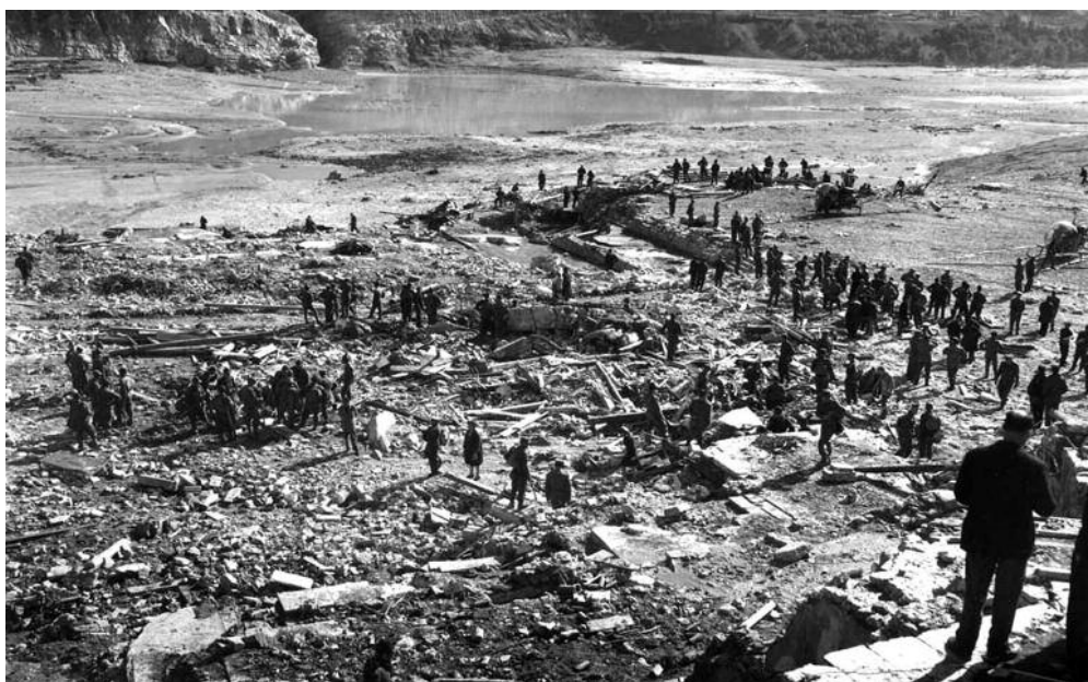
Una visione della tragedia a pochi giorni dal crollo del Toc nel lago
